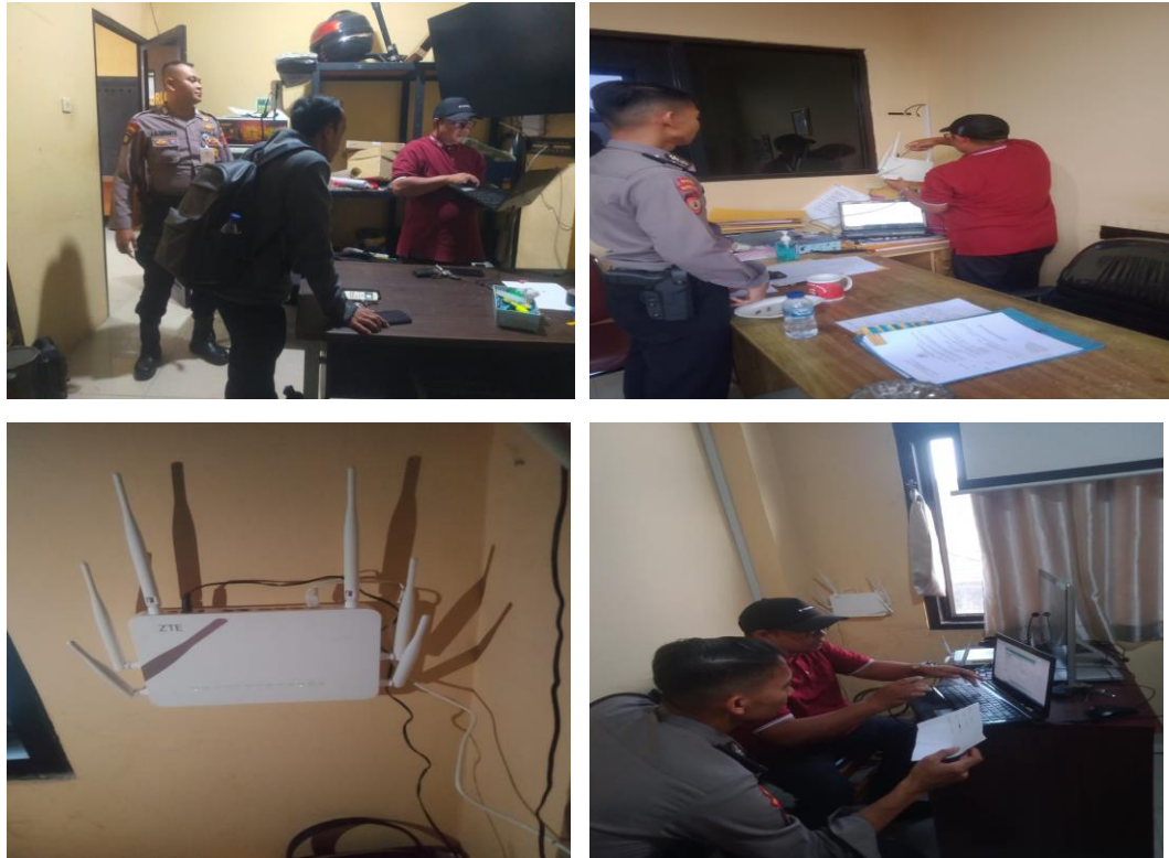
Gambar 9. Pemasangan Jaringan Internet
